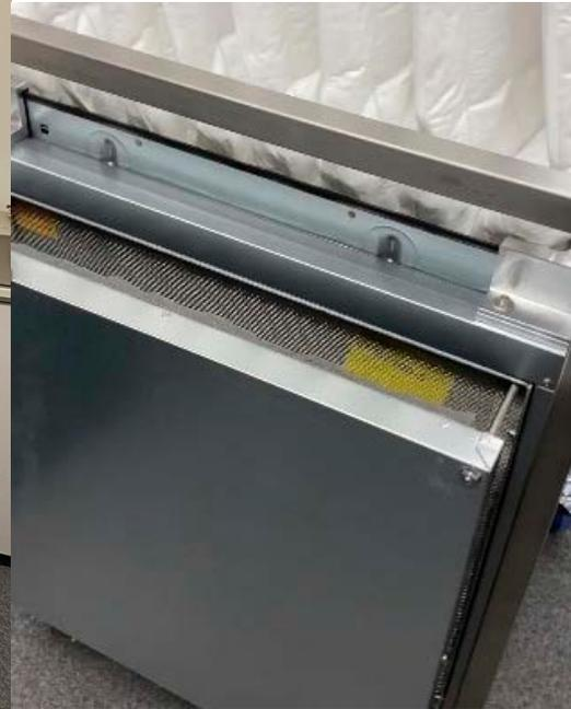
Dann wurde die übrig gebliebene Abdeckplatte zum Schallschutz mit Gewindestangen und Kontermuttern vor dem Gitter befestigt. Der Abstand beträgt ca 12 cm um einen guten Lufteinlass zu gewährleisten. Die Platte wurde noch mit noppigen PU-Schaum als Schallschutz beklebt.
